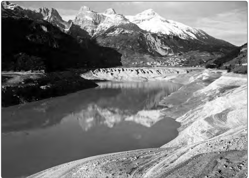
Sopra: novembre 1952. Spillamento del Lago di Molveno. Svaso a quota 750 Sotto: novembre 1952. Spillamento del Lago di Molveno con svaso a quota 740
