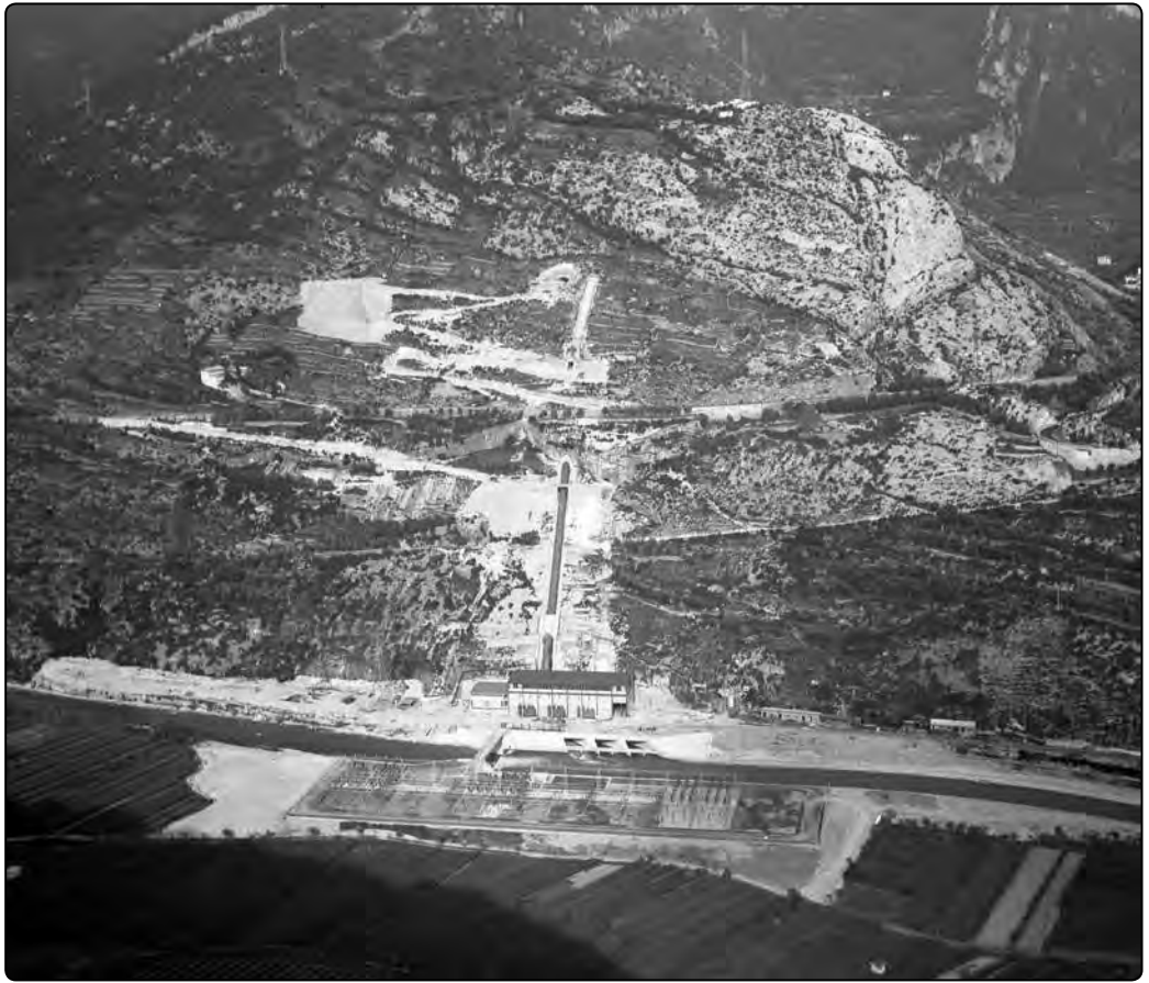
Centrale di Torbole. Veduta aerea del complesso
