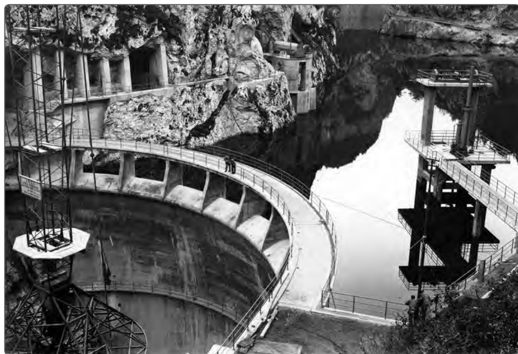
Sopra: marzo 1957. Diga di Ponte Pià. Panoramica del cantiere sul lato monte Sotto: autunno 1957. Diga di Ponte Pià. Panoramica della diga dalla cabina di manovra
