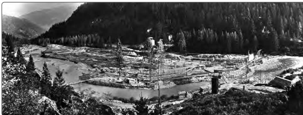
1950. Il cantiere delle opere di presa sul Sarca di Genova in località S. Stefano
