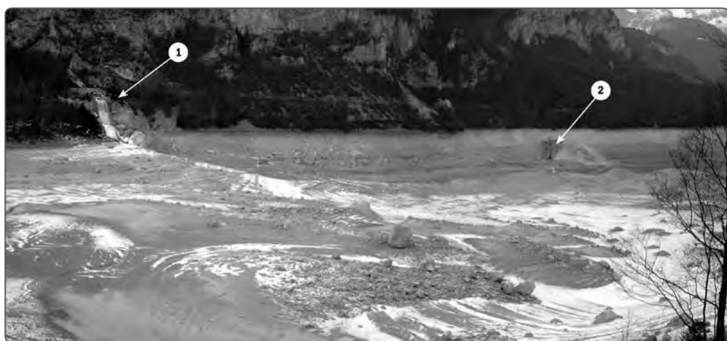
La parte meridionale del lago di Molveno fotografata nel 2005 durante i lavori di manutenzione. Punto 1: lo sbocco del canale di gronda. Punto 2: lo sbocco dello scarico della centrale di Nembia
