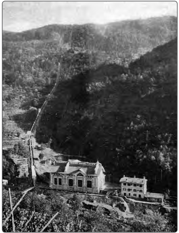
Centrale di Pozzolago
