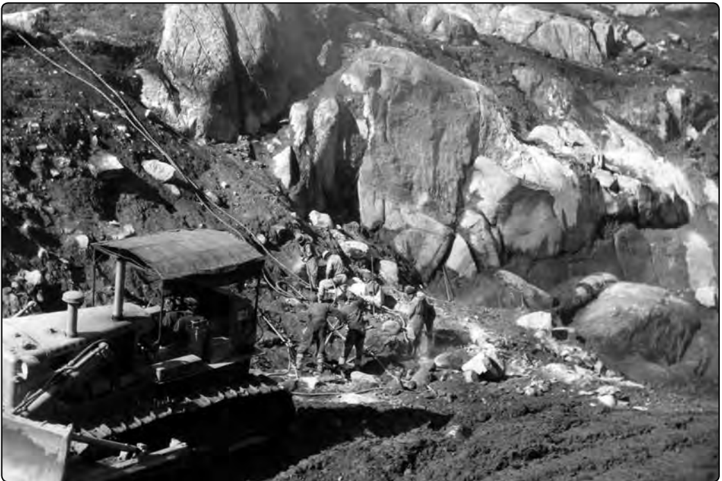
Sopra: scavi ai Lagbetti di Cornisello Sotto: costruzione strada Nambrone - Lagbetti di Cornisello
