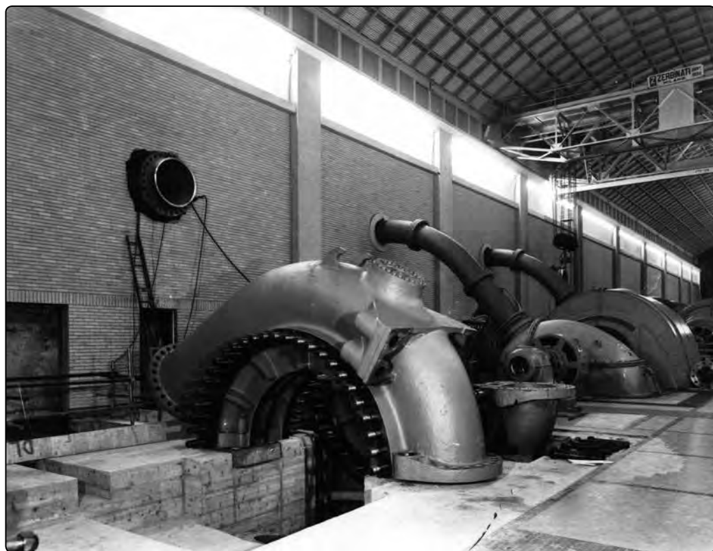
Centrale di Santa Massenza. Sala macchine, lavori di montaggio
