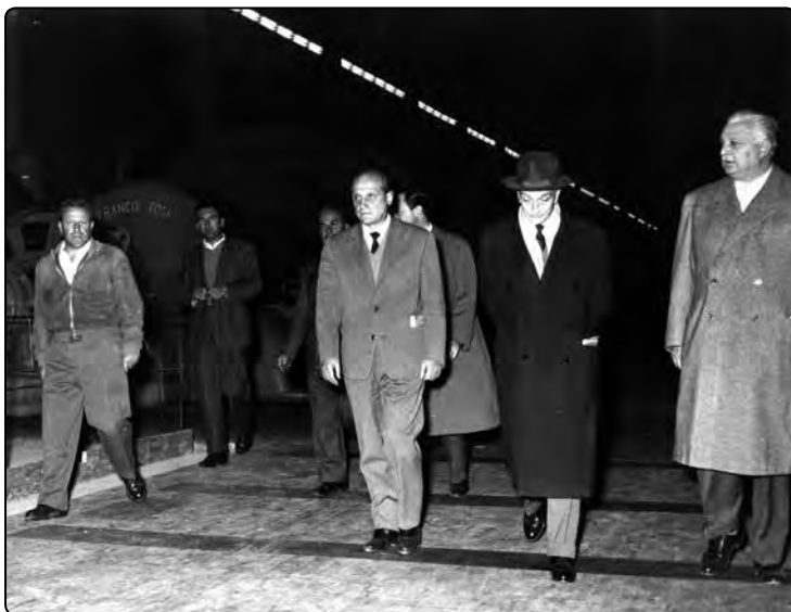
L'ing. Dante Ongari guida l'on. Antonio Segni alla visita della centrale
