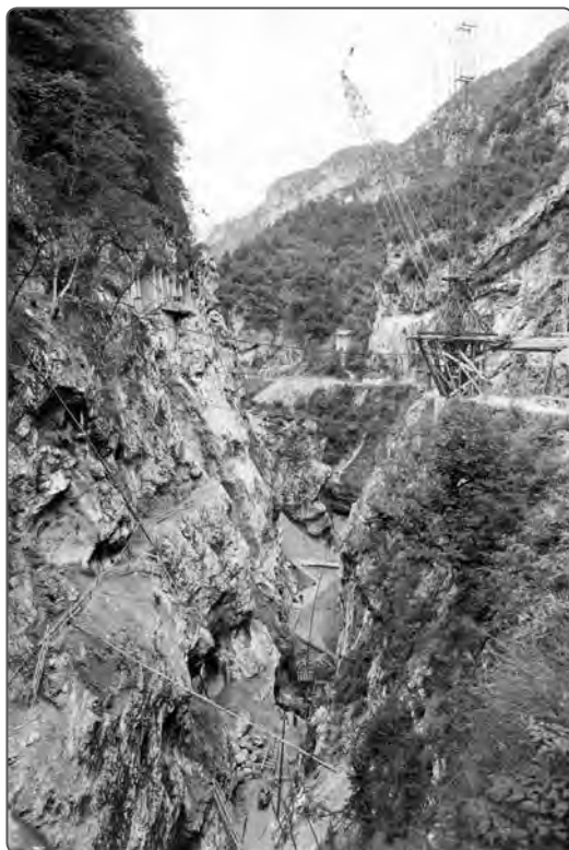
1956. Forra della Scaletta. Si gettano le fondamenta della diga di Ponte Pià
