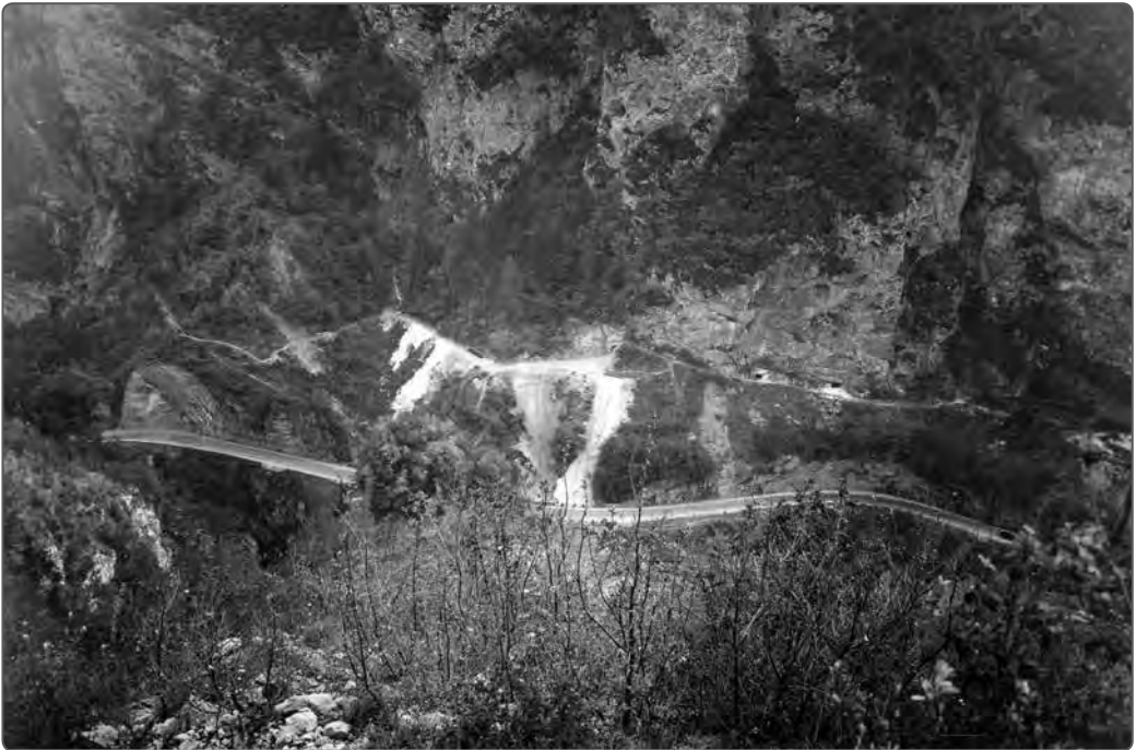
Sopra: febbraio 1957. Nuova variante della strada della Scaletta. Tratto esterno, oggi spostato in galleria Sotto: maggio 1954. Veduta del tracciato tra le progressive 1250 e 1630. Più in basso si noti la vecchia strada che trapassa il Doss. All'estrema sinistra si intravede l'imbocco del vecchio Ponte del Burrone che immetteva sulla strada in sponda sinistra
