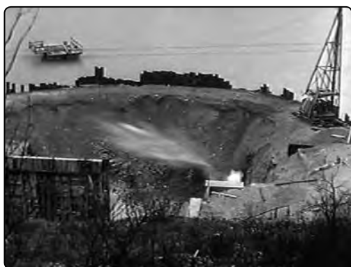
Tura per consentire la costruzione della presa sul lago di Cavedine
