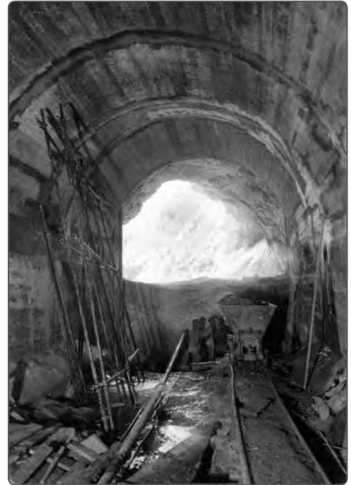
Sopra: giugno 1956. Cantiere di Ponte Pià. Galleria di derivazione a Santa Massenza. Casseri metallici per il getto di rivestimento della galleria
