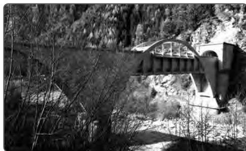
1994. Ponte canale sul Sarca di Nambrone
