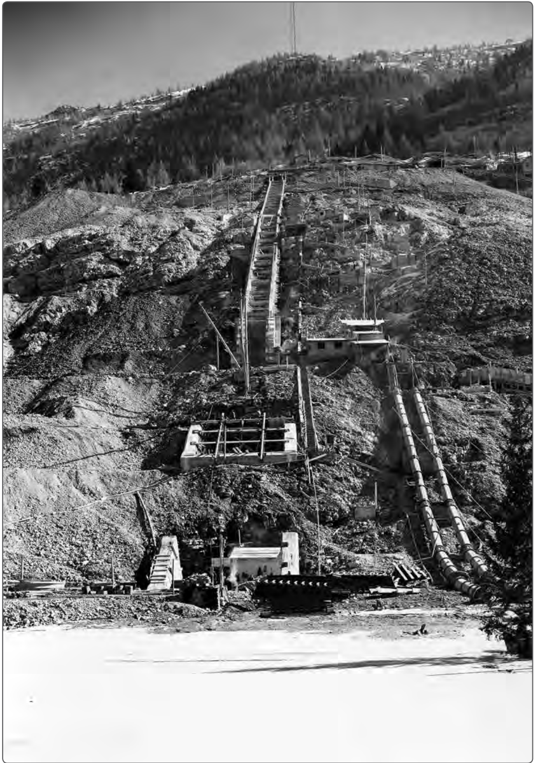
Marzo 1953. Cantiere del Lago di Molveno, bocche di presa a quota 727.75 e 713, con il piano inclinato per le paratoie di emergenza
