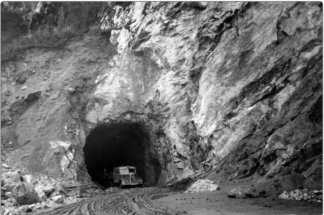
Sopra: luglio 1955. La terza galleria in fase di scavo Sotto: dicembre 1954. Sbocco della prima galleria. Si noti il "mitico" OM Taurus di Dino Armanini
