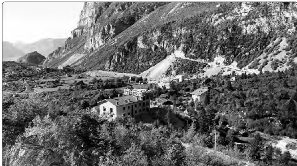
Nembia di S. Lorenzo in Banale, veduta degli edifici di servizio del cantiere del lago di Molveno, sullo sfondo l'entrata della centrale in caverna
