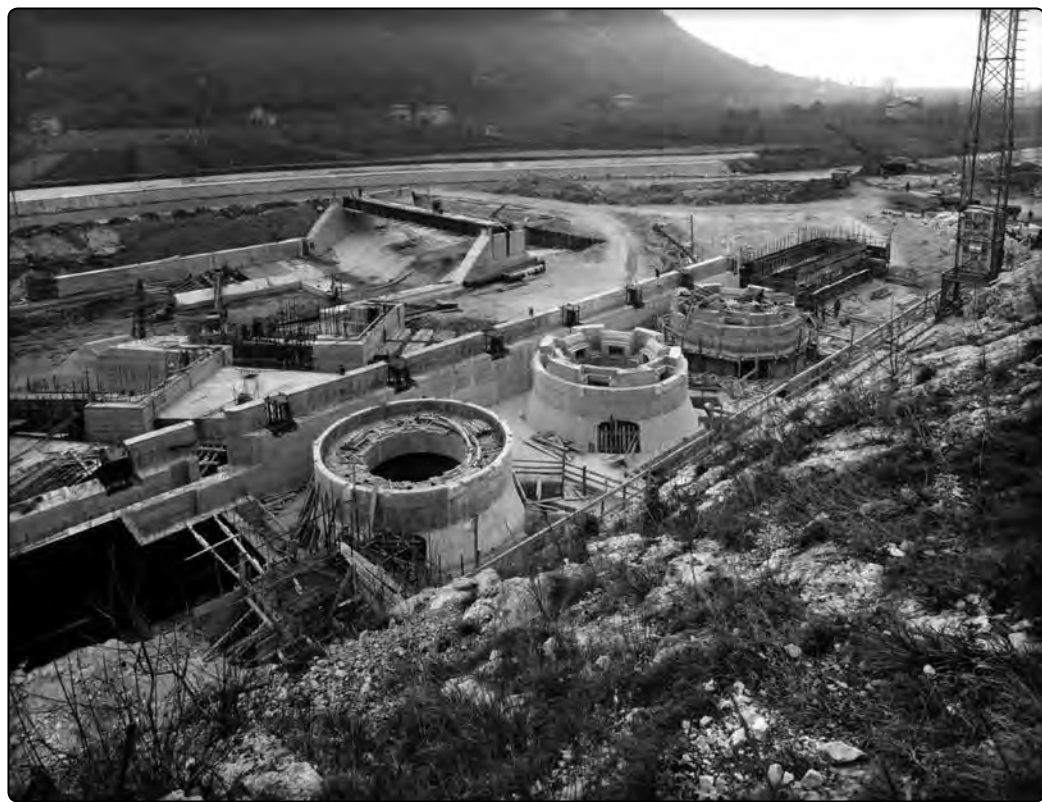
Centrale di Torbole in costruzione
